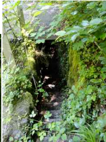
Einer der Einstiege in die unterirdischen Anlagen.
