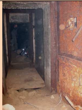
Panzertür an der Fallgrube mit abgesenkter Fallgrubenabdeckung.
