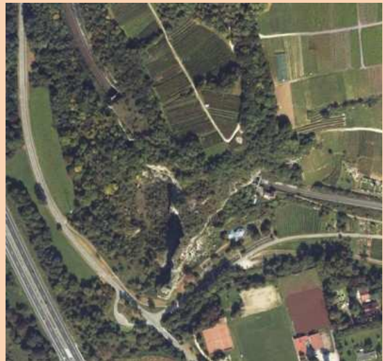
Aktuelles Luftbild. Große Teile des Felsmassivs wurden nach dem 2. WK weggesprengt.
