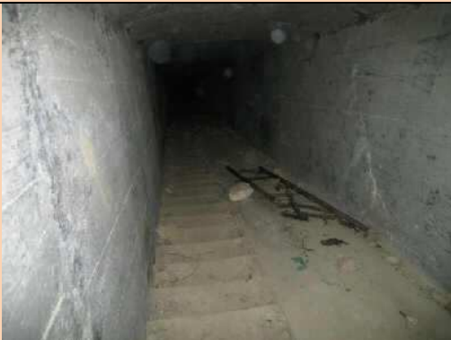
Treppenabgang zu Fenster 1
