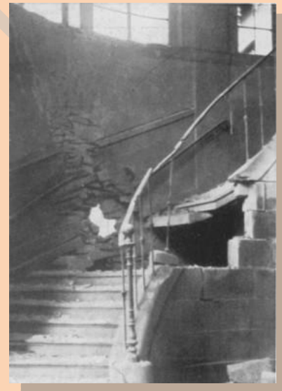
Cage d'escalier dans la gare d'Altkirch
