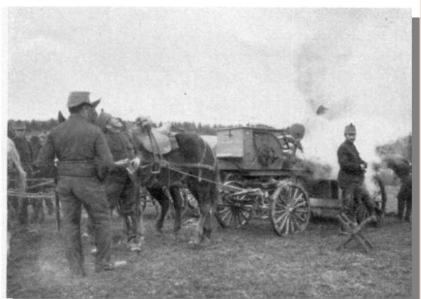
Wagen zum Kabelaufwinden
